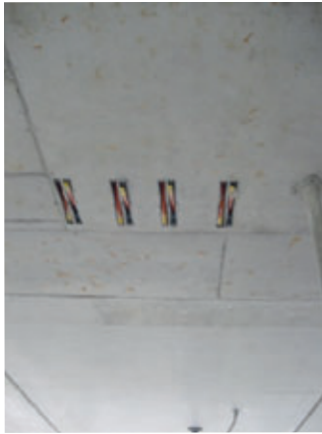
Auslass der Rohrenden zum Anschluss an die Hauptleitungen
