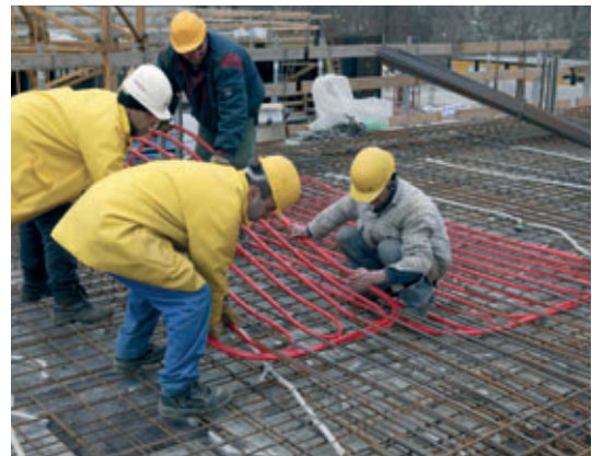
Einbau der vorgefertigten Rohrregister zwischen die Bewehrungslagen (Copyright: Rehau AG + CO)
