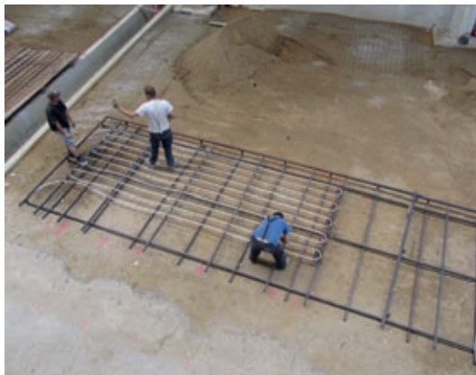
Vorgefertigte Rohrregister auf einer Bewehrungsmatte
