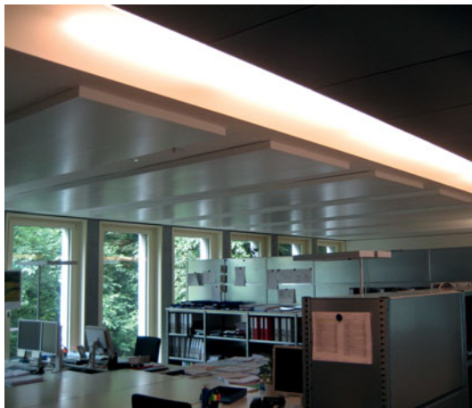
Externe Bauteilaktivierung mit aufgesetzten Blechkassetten
