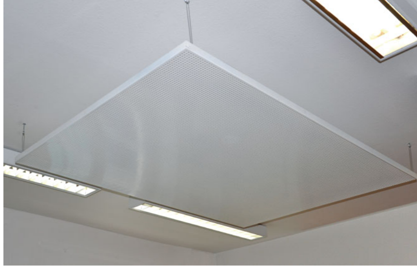
Einzelnes Deckensegel für die nachträgliche Befestigung an der Decke
