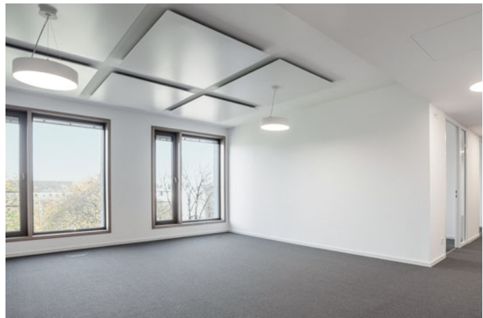
Ergänzende Deckensegel in Verbindung mit einer integrierten Bauteilaktivierung
