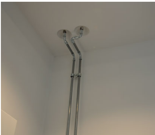
Thermische Steckdose für den Anschluss von zusätzlichen Deckensegel
