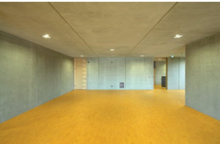
Sichtbetonoberfläche mit Akzentuierung der Elementfugen
