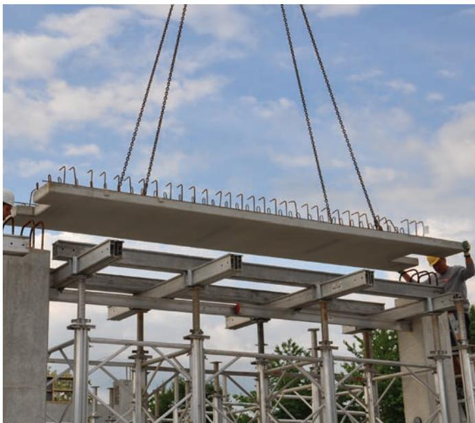
Bild 12: InnoBeam während der Montage
