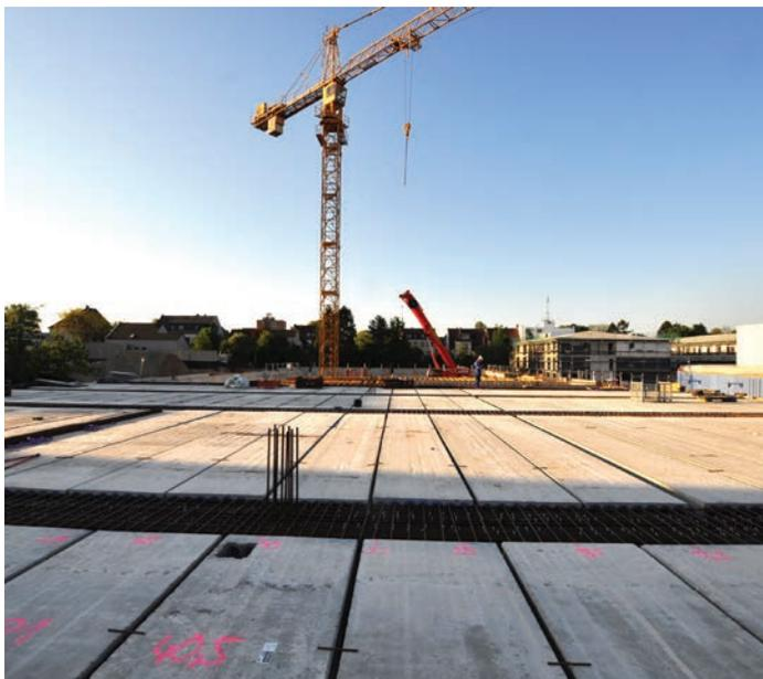
Bild 9: Decke über EG vor dem Betonieren
