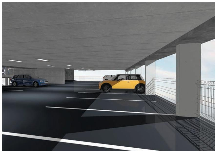
Bild 2: Deckenunterseite bestehend aus dem deckengleichen Unterzug InnoBeam® und den senkrecht dazu verlaufenden vorgefertigten Deckenplatten
