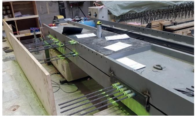
Anordnung der gespannten Litzen im Spannloch entsprechend den verschiedenen Produkten wie z.B.: Gurtstreifen, Balken, Rippendecken...
