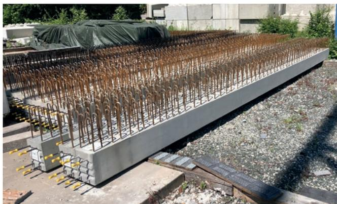
Zentrisch vorgespannte Balken mit schlanken Querschnitts-abmessungen erzielen eine hohe Tragfähigkeit
