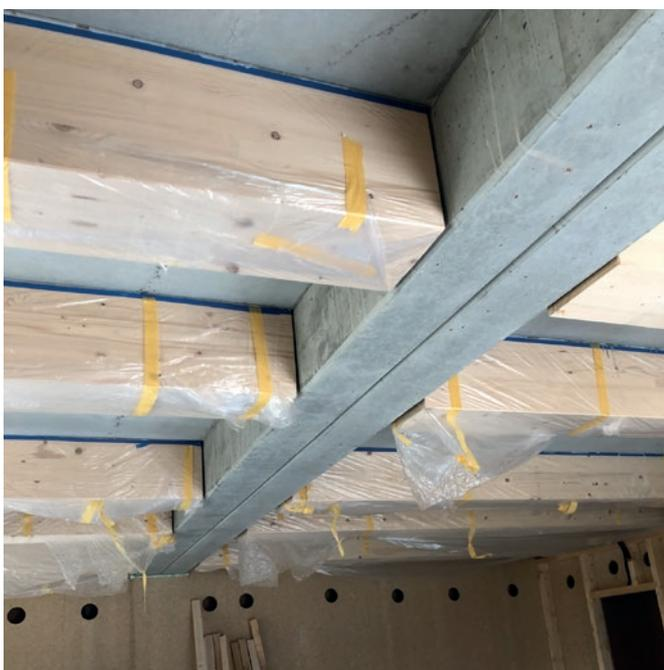
Einsatz der vorgespannten schlanken Balken als Auflager für die einachsrig gespannten Holz-Beton-Verbunddecken (HBV-Decken)
