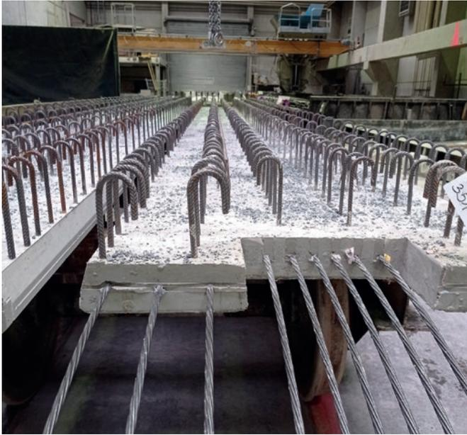
Vorgespannte Gurtstreifenplatte für die Herstellung von Flachdecken mit vorgefertigten einachsig wirksamen Deckenplatten
