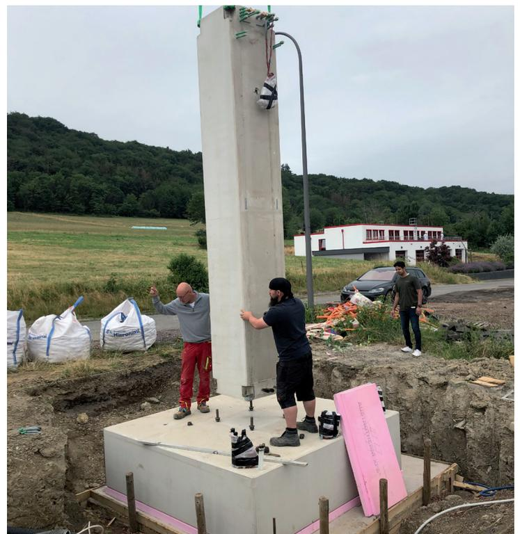
*Bild.08: Zusammenbau von Energiesäule mit dem Fundament*
