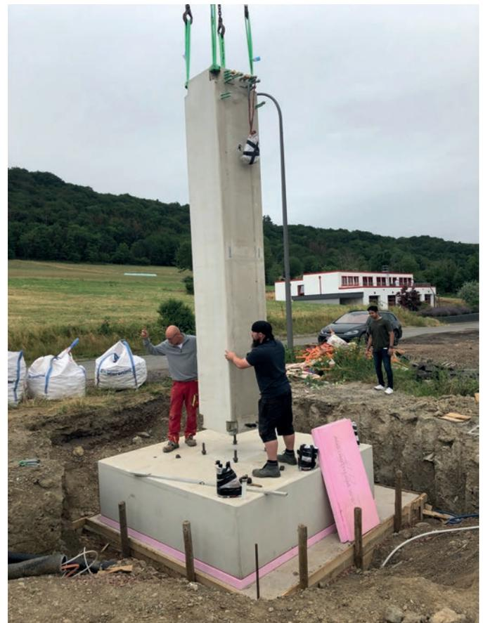
**Bild 6** Montage der Energiesäule mit den vorgefertigten Elementen für das Fundament und den Turm
