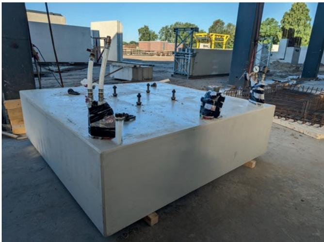
**Bild 5** Vorgefertigter Fundamentblock für die Energiesäule
