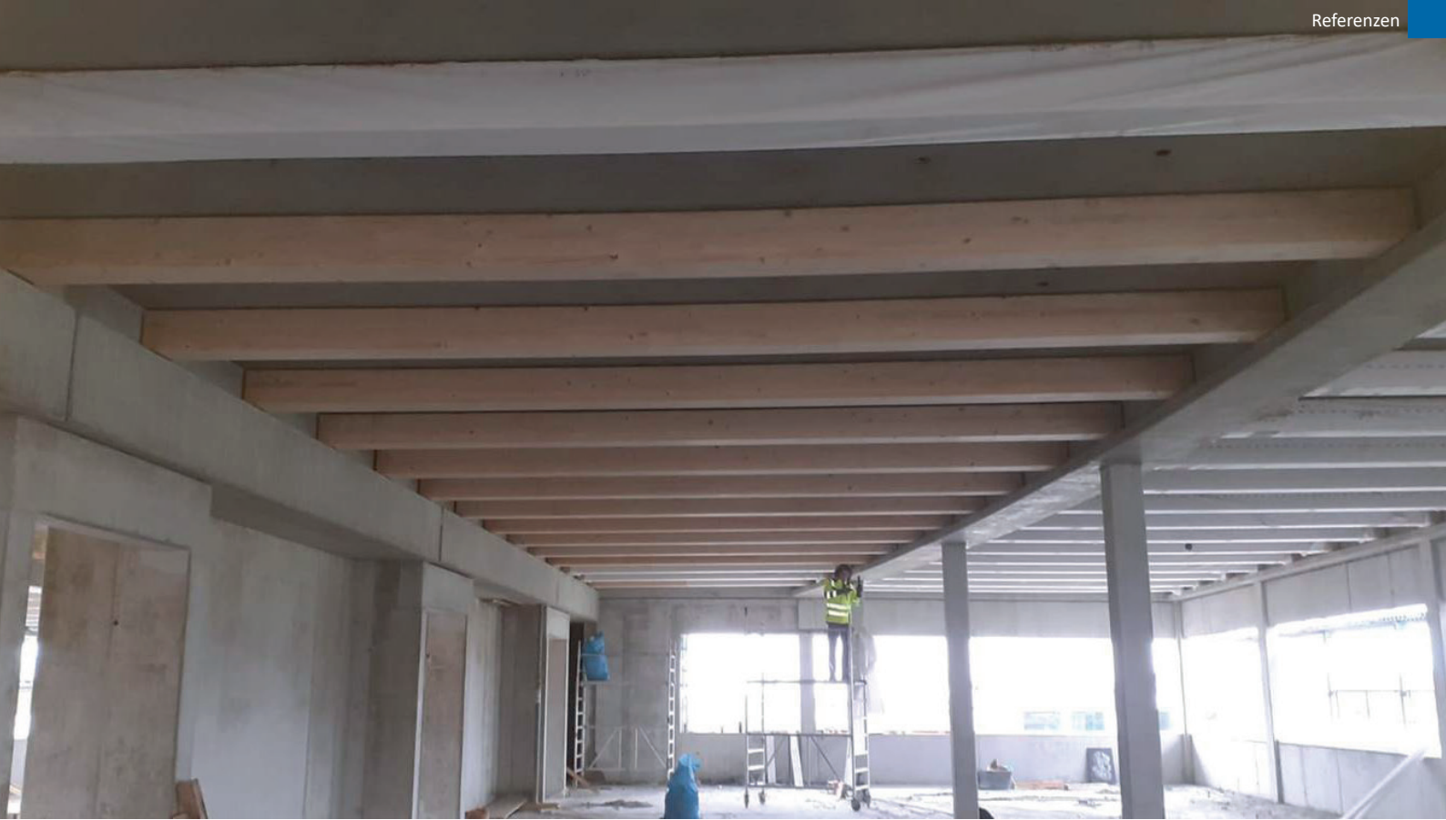
HBV-Decken nach der Entfernung der Hilfsjoche
