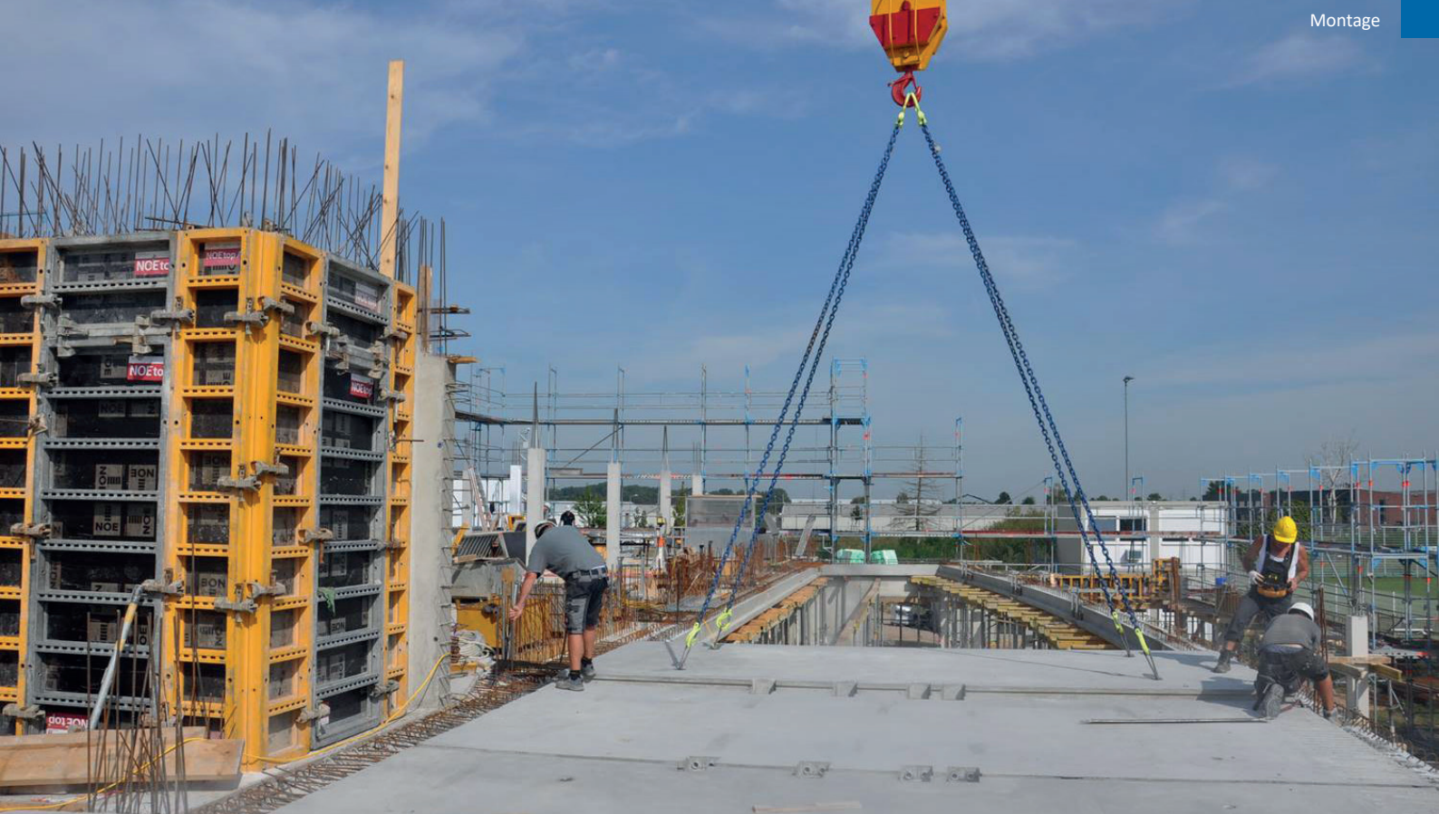
Montage der vorgefertigten HBV Deckenplatten
