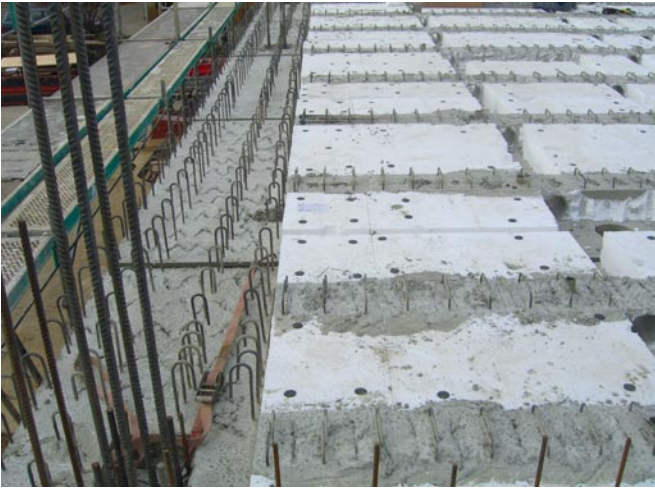
Vorgefertigte Platten mit der integrierten Bügelbewehrung für den deckengleichen Unterzug
