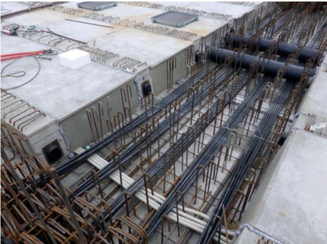
Anordnung der Vorspannbewehrung innerhalb der vorinstallierten Bügelbewehrung
