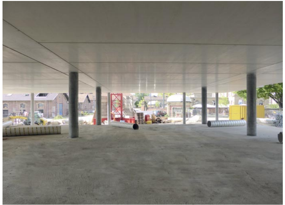
Ergebnis: weitgespannte Flachdecke mit großzügigen Räumen
