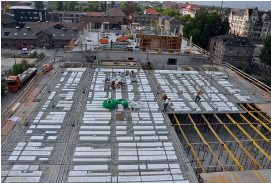
Weitgespannte Deckenelemente mit den vorgesehenen Gassen für die Vorspannbewehrung
