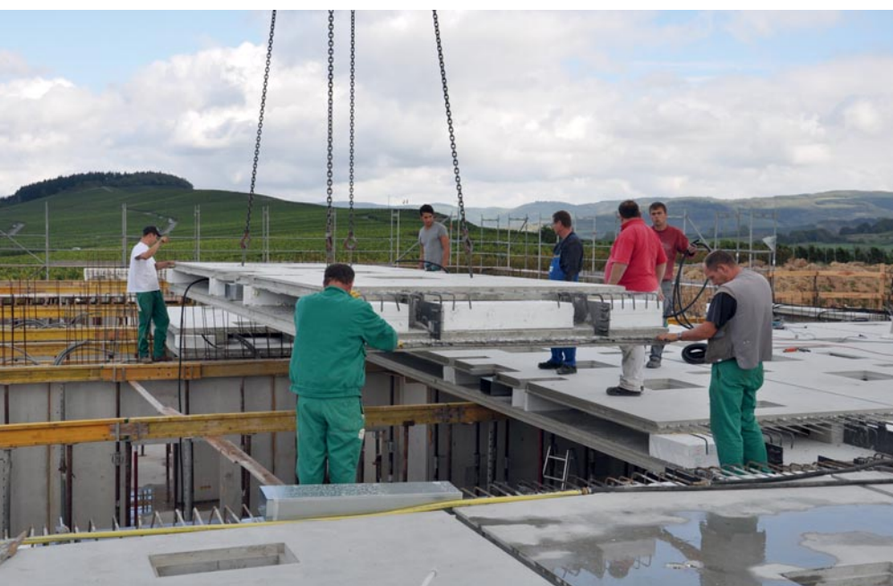
Projekt mit Ceiltec-B: vorgefertigte Deckenplatten mit Sandwichquerschnitt
