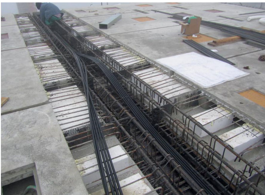
Litzenbündel in oberer Lage über der Stütze als Stützenbewehrung
