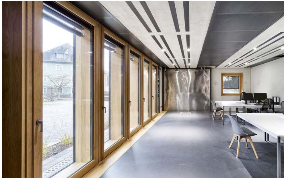
Bild 1 Blick in den Innenraum von InnoLiving® mit Ansicht an die GVI®-Wand, die weitgespannte Betondecke mit den integrierten Akustikabsorbern und dem Energiefenster
