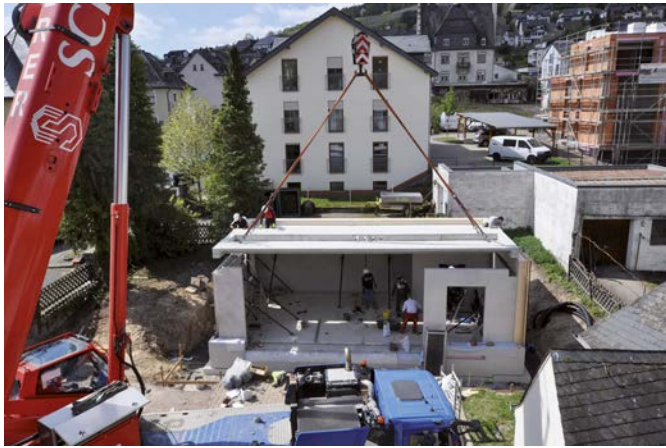
Bild 3 Montage der weitgespannten Deckenplatte für eine Moduleinheit
