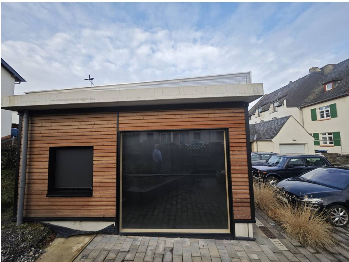
Eine schwarze Wand hinter Glas: Mit diesem Modul lässt sich Wasser erhitzen. Foto: TV/Hans-Peter Linz
