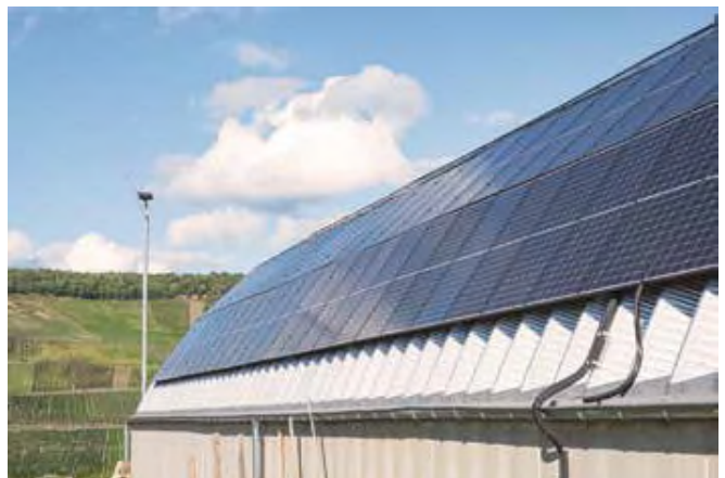
Freitragende Hallenbogenkonstruktion mit PV-Belegung
